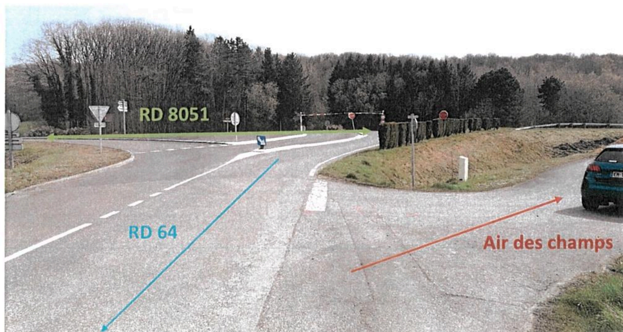
Croisement entre la route communale « Air des champs » avec la RD 64, avec en fond la RD 8051 – BE Dumay
