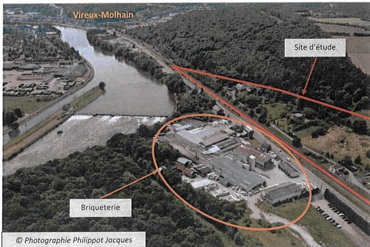
Vue aérienne du site d'étude en direction du Sud-Ouest et de Vireux-Molhain
