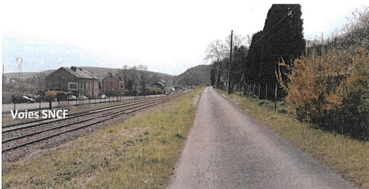
Chemin communal d'accès des dernières parcelles de faible largeur – BE Dumay
