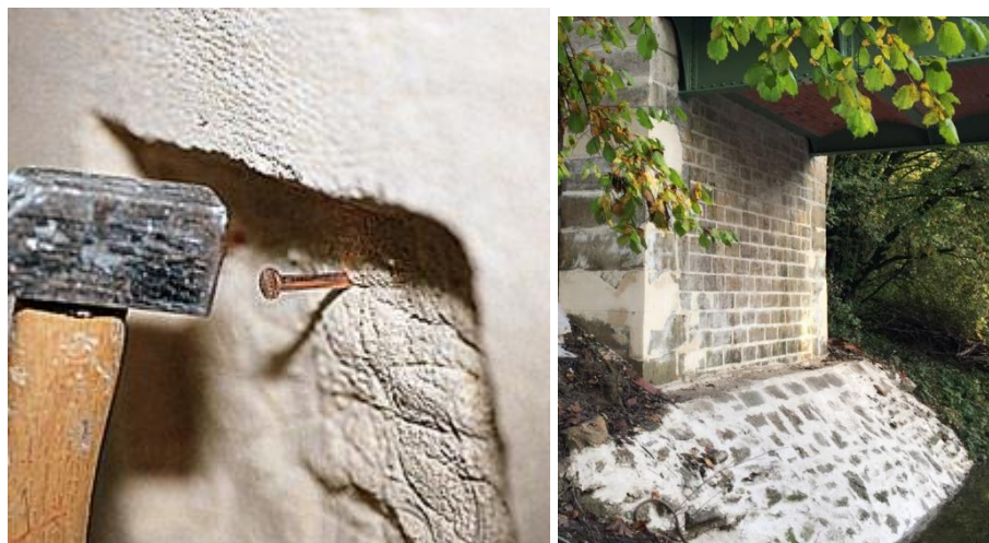
Exemple d'application de clous en laiton et d'un mortier de reconstitution de pierre sur OA
